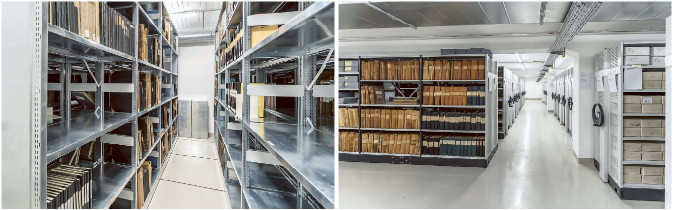
Dank der Unterstützung eines Fachplaners konnte die Fahrregalanlage in den vorhandenen Raum mit seiner Betonpfeilerstruktur eingepasst werden, wo in Zukunft die historischen Dokumente gelagert werden.
