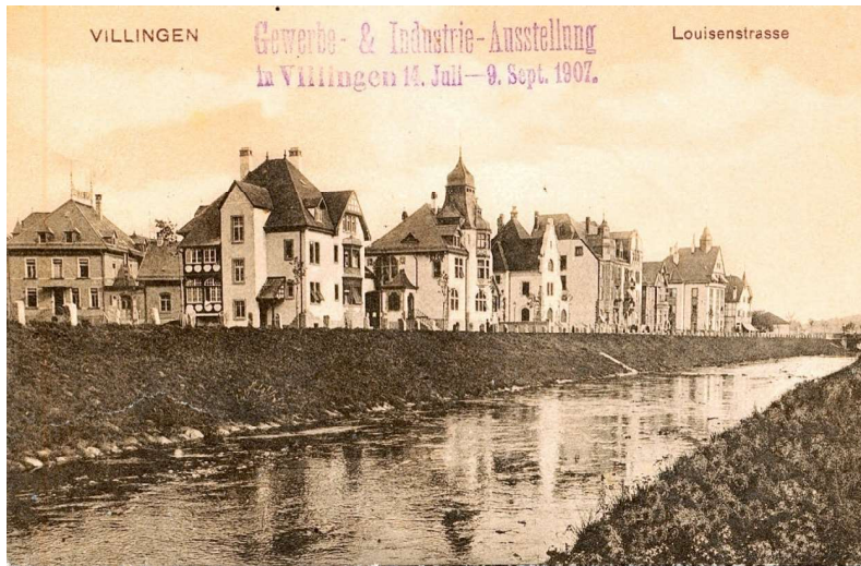
Blick in die Vergangenheit: Im Jahr 1907 konnte man gerade einmal erahnen, wo heute der schicke Bau des Landratsamtes steht.
