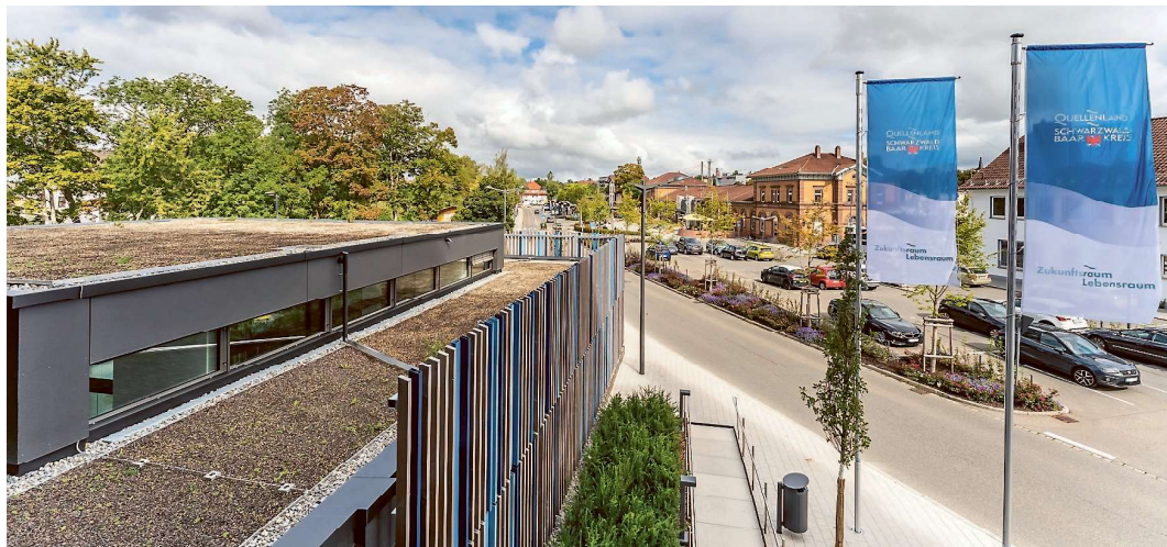
Nach rund drei Jahren Bauzeit sind mehrere Ämter des Landratsamtes Schwarzwald-Baar-Kreis nun in das neu sanierte Verwaltungsgebäude An der Brigach eingezogen. Fotos: Katja Wickert
